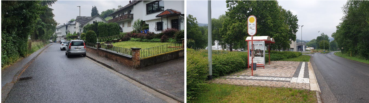
Abbildung 6: Straßenverkehrsfläche An der Embsmühle (links) und Bushaltestelle Embsmühle (rechts) Quelle: Eigene Aufnahme
