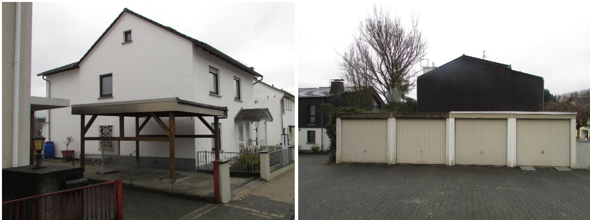
Abbildung 21: Carport entlang der Gartenstraße (links) und Garagenreihe entlang der Straße Zeilring (rechts) innerhalb des Plangebietes
