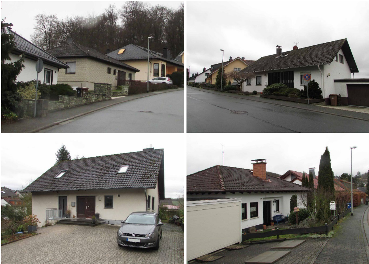
Abbildung 15: Eingeschossige Einzelhausbebauung innerhalb der Teilfläche 1 des Plangebietes
