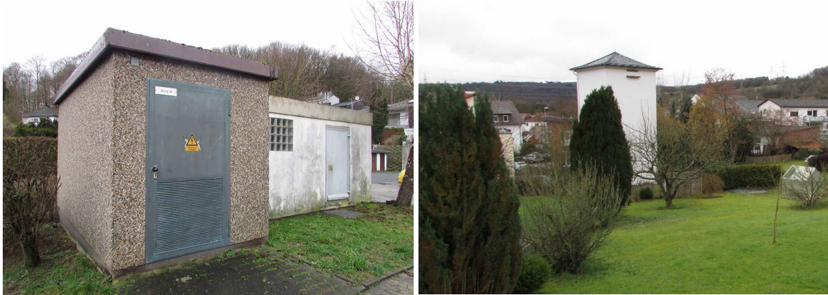
Abbildung 14: Trafostation an der Straße Zeilring (links) und Stromversorgungsturm (rechts) innerhalb des Plangebietes
